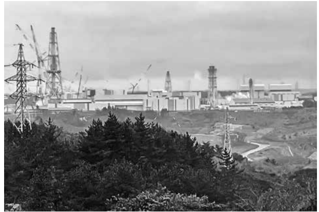
PRセンターから見た再処理工場（稼働はしていない）
